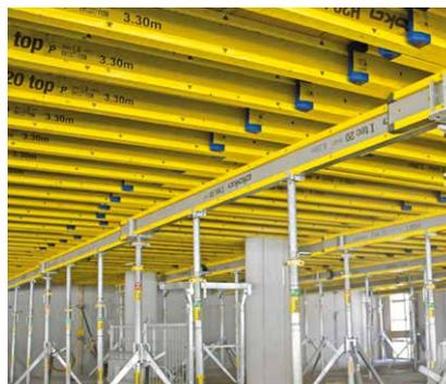
In den Dokaflex-Deckenschalungen überzeugt die 3-SO Platte mit hohen Einsatzzahlen und äußerst geringem Nacharbeitsaufwand.
