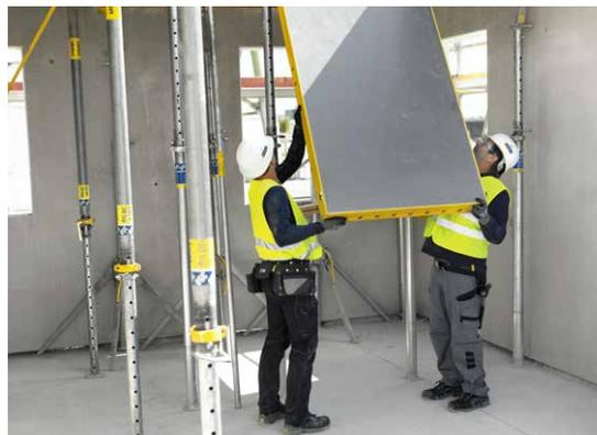
Montaggio in sicurezza da terra della cassaforma ad elementi per solai DokaXdek
