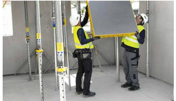
Sicherer Aufbau der DokaXdek Element-Deckenschalung vom Boden aus
