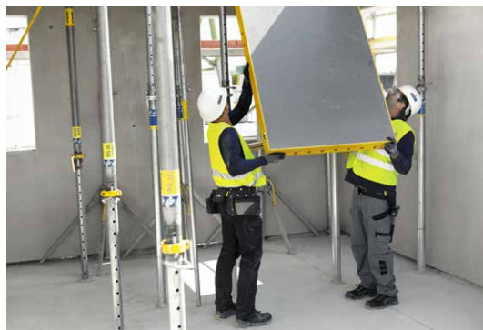
DokaXdek-kassetten er et lett og fleksibelt 2-manns kassettsystem.
