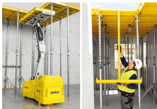
Lavorare in modo ergonomico con DokaXbot* e i tavoli DokaXdek-I* (*versioni demo).
