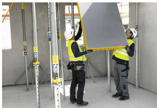
La cassaforma ad elementi per solai DokaXdek è un sistema leggero e flessibile posizionabile agevolmente da due persone.
