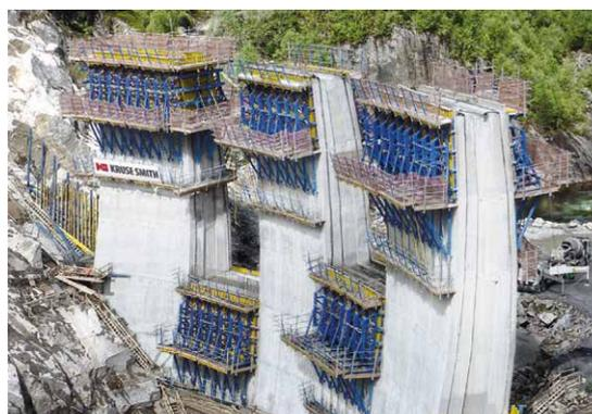
Beim Projekt Dam Sarvsfossen in Norwegen konnten mit der Sperrschalung D35 Blockhöhen von 5 m realisiert werden. Die daraus resultierende Minimierung der Blockfugen führte zu einer erheblichen Beschleunigung des Baufortschritts.
