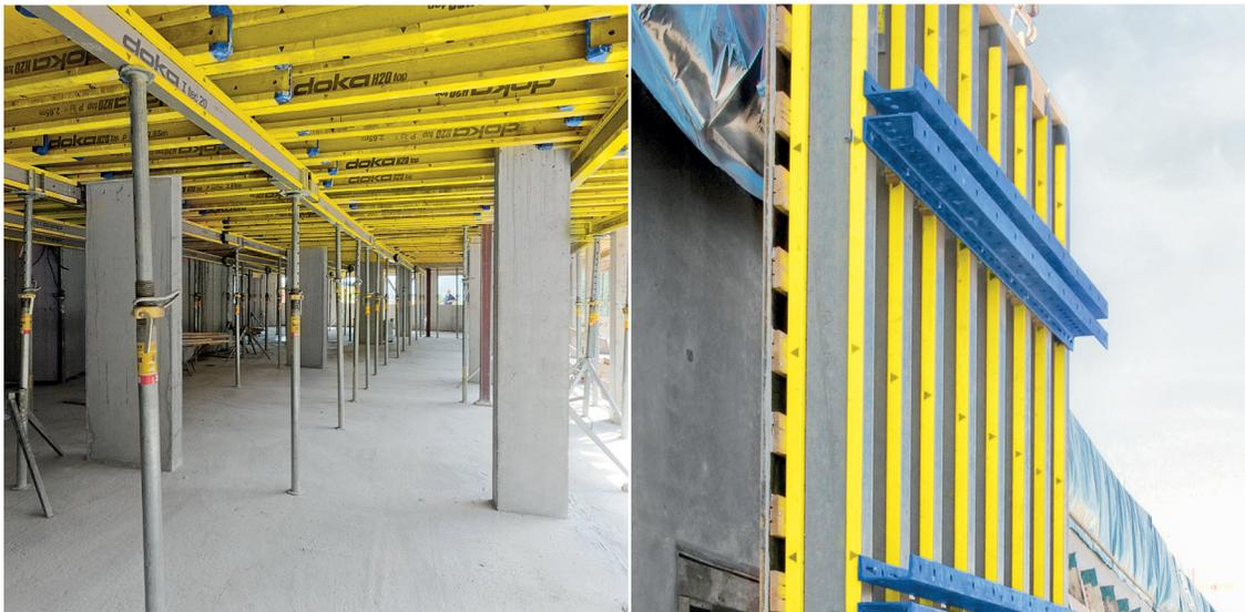
Grâce à la force portante élevée de la poutrelle composite I tec 20, il faut moins de composants. C'est une économie de matériel et cela accélère l'avancement du chantier.
