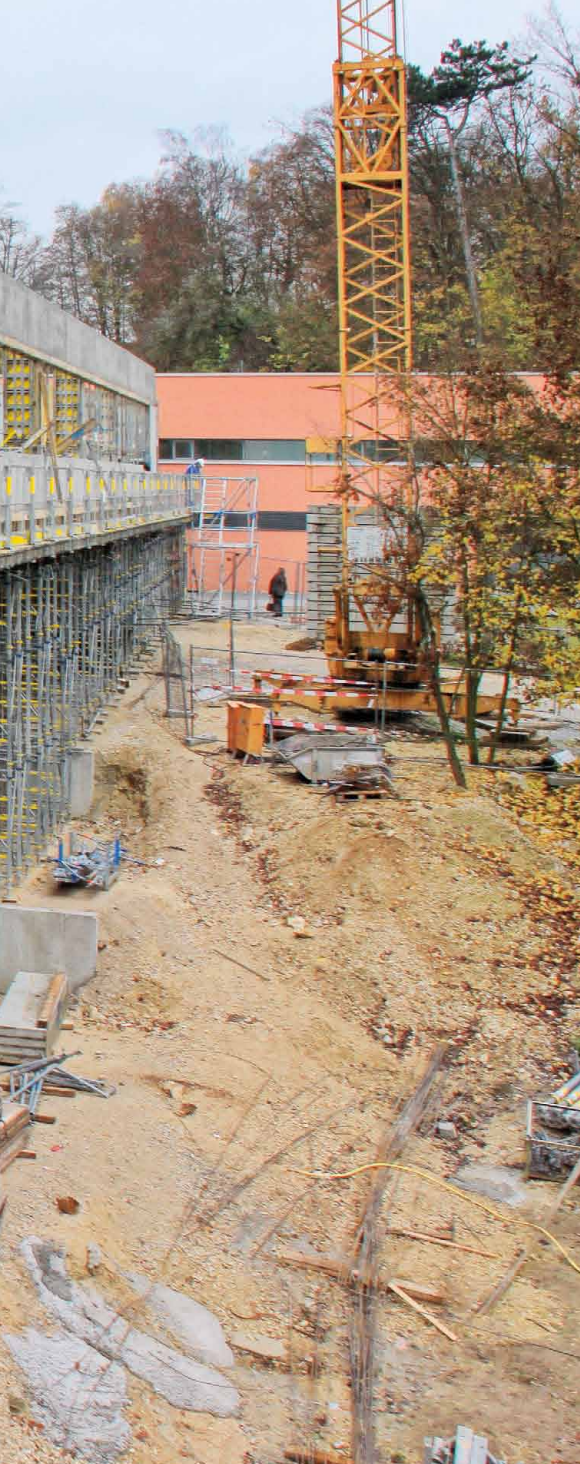
▲ Das Traggerüstsystem Staxo 100 passt sich dem trapezförmigen Grundriss ebenso gut an wie den unterschiedlichen Aufstandshöhen.
