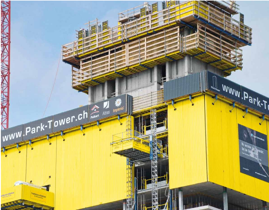
▲ Das für das gerüstlose Bauen eingesetzte Windschild mit einer Abwicklungslänge von 100 m wird hydraulisch immer um Stockwerkhöhe umgesetzt.
