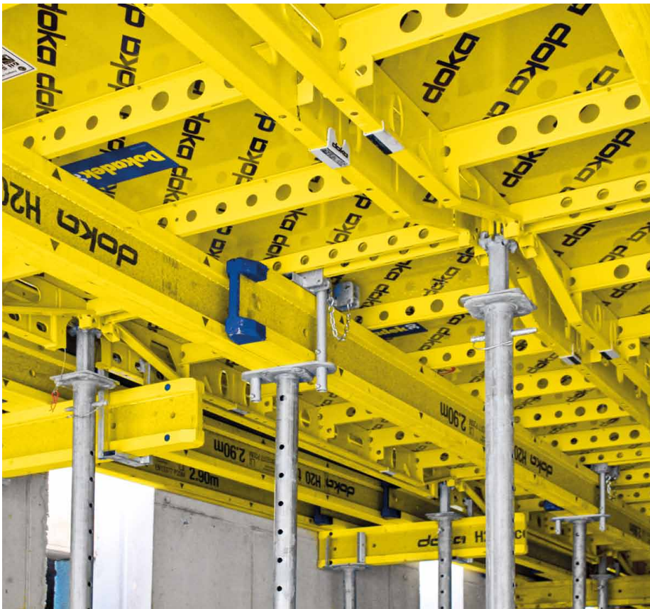
▲ Die Zusatzmaßnahmen für Deckenstärken von 30 bis 50 cm – Ein- und Ausbau der Trägeraufnahmen, Holzschalungsträger und Deckenstützen – sind in nur 0,088 h/m 2 erledigt.
