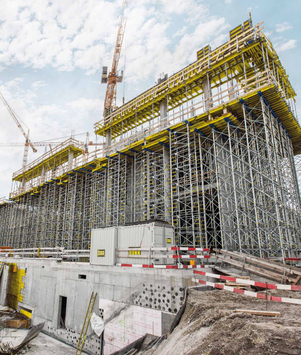
▲ Staxo 100 ist mit seinen robusten Stahlrahmen und einer Lastaufnahme von bis zu 100 kN/Stiel für große Unterstellungshöhen und hohe Lasten konzipiert.
