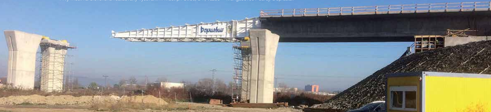
Prvý most na Slovensku realizovaný vysúvaním: Most pri Štrbe, D1, Važec – Mengusovce / zdroj: Doprastav
