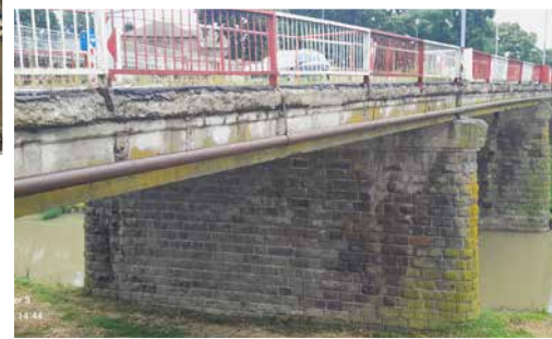
Stav mosta pred rekonštrukciou
