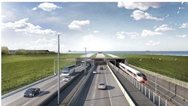
Künftig dient das Portal als Übergang von Land zu Wasser für die fünf Tunnelröhren, in denen sich eine vierspurige Straße, eine zweigleisige Bahnstrecke sowie ein Wartungskorridor befinden.
