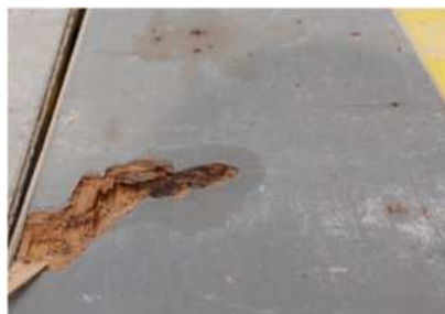
Praskliny v preglejke > 10 cm dlhé
