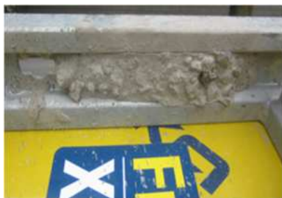
Vnútorňý profil panelu vyplnený betónom
