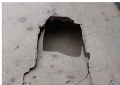
Otvory a prevrtanie s priemerom > 2 cm
