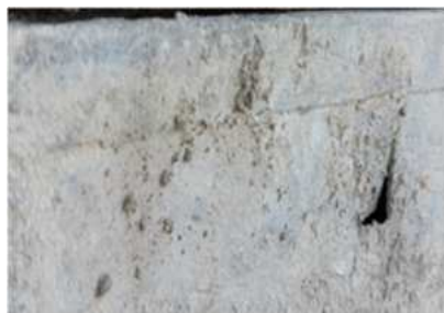
Otvory v profiloch => nutné zváranie
