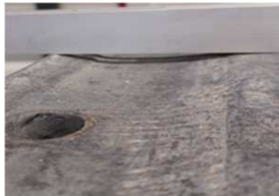
Deformácia panela
