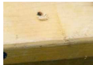
✓ Otvory po klincoch s priemerom < 4 mm na drevených materiáloch
