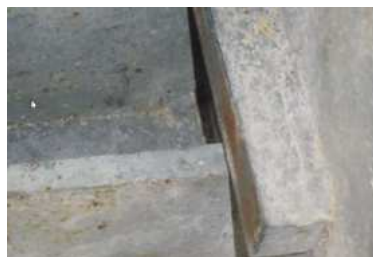
✓ Selektívne bez pozinkovania alebo hrdzavé miesta do 5 cm 2 na pozinkovaných oceľových častiach
